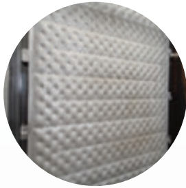
รูปแผ่นทำน้ำเย็นที่ปกติ
